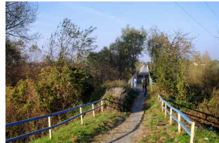
Kładka nad rzeką Białą, ul. Chemiczna, Tarnów, fot. J. Tarański
