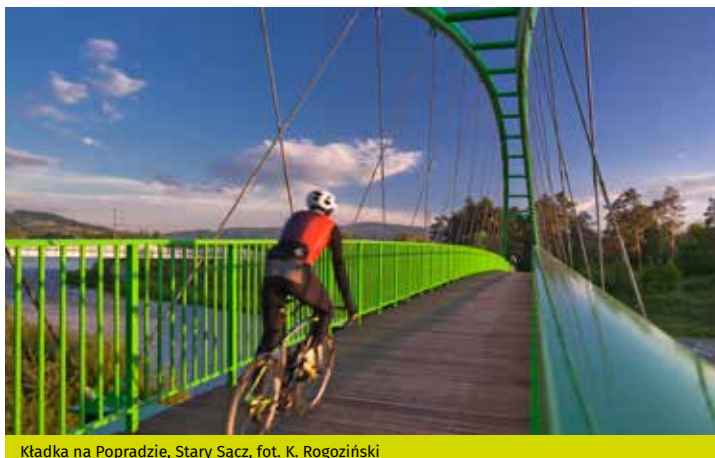
Kładka na Popradzie, Stary Sącz, fot. K. Rogoziński
