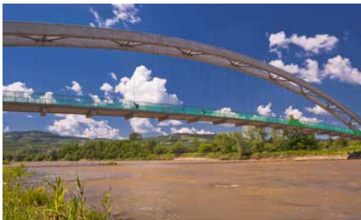
Kładka pieszo-rowerowa w Łącku, fot. K. Rogoziński
